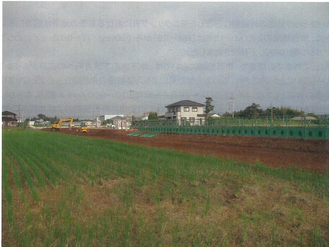
水田復旧工および新設仮囲いの状況（9月28日）
