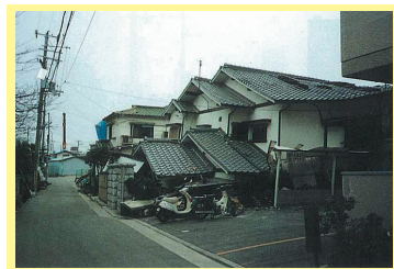
倒壊した被災住宅 平成7年度阪神・淡路大震災
