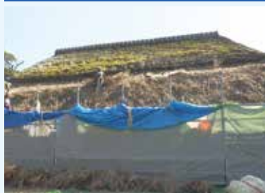
下から解体されていきます
