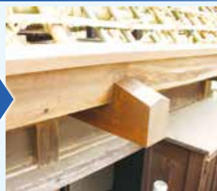
新しくなった梁
