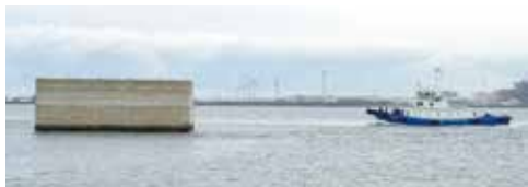
現在もケーソンは防波堤の延伸工事に使用されている
