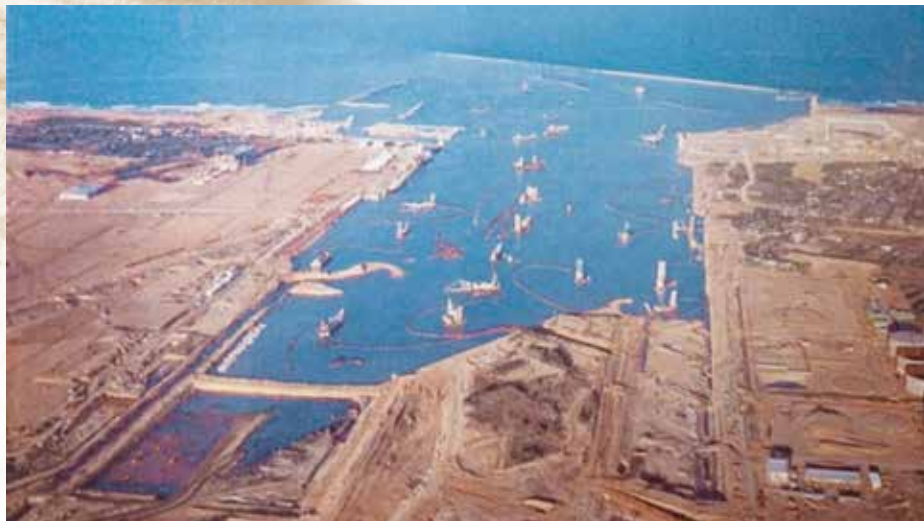
左上／鹿島港開発前の海岸線。鹿島砂丘が広がっていた※ はおおよその現在の中央航路の位置 右上／中央航路にひしめく浚渫船(昭和44年頃) 左下／防波堤ケーソン据え付けの様子。当時は人力でおこなっていた(昭和44年頃) 右下／鹿島港港口付近の造成状況(昭和45年頃)
