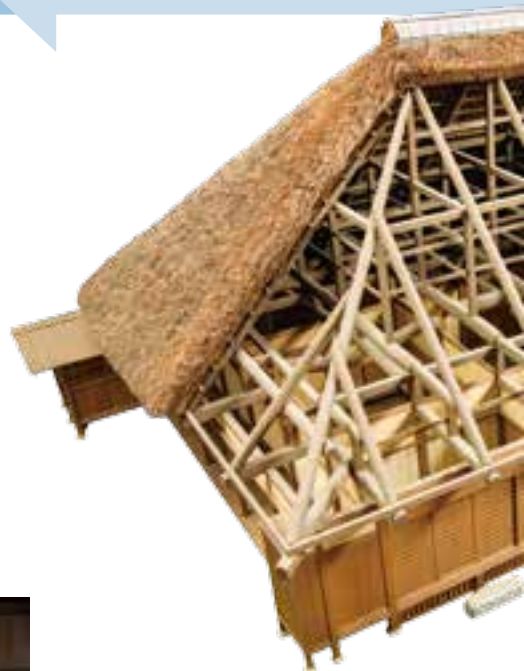
復元される茅葺屋根。葦の長さをそろえて束ねる、屋根に敷き並べる、刈り込むなど多くの工程を経て仕上げる(上・左)。
