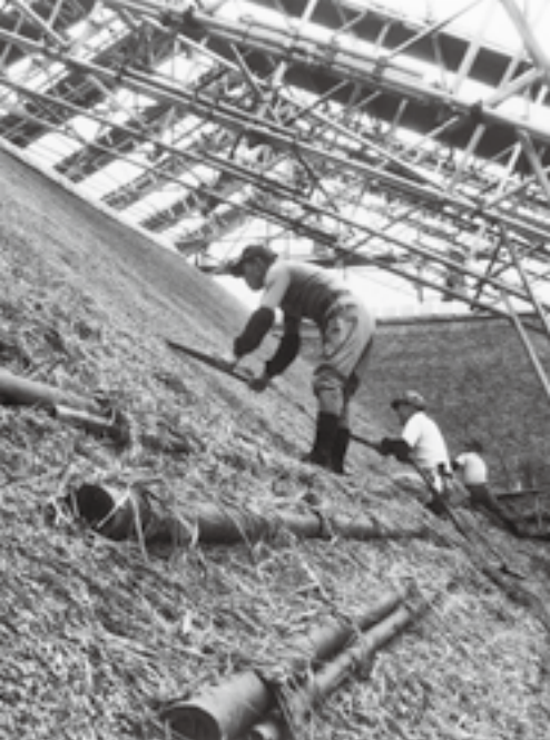
復元される茅葺屋根。葦の長さをそろえて束ねる、屋根に敷き並べる、刈り込むなど多くの工程を経て仕上げる(上・左)。
