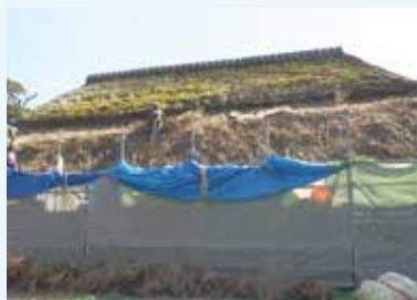
下から解体されていきます
