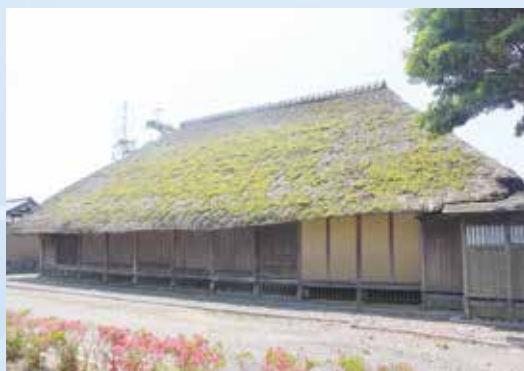
苔が生えて全体的に下がってきている北側屋根
