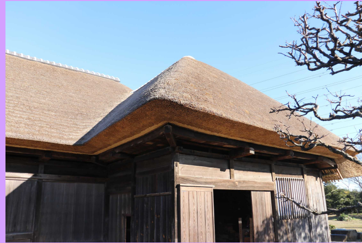
きれいに切り揃えられ 足場が撤去され、葺替完了です
