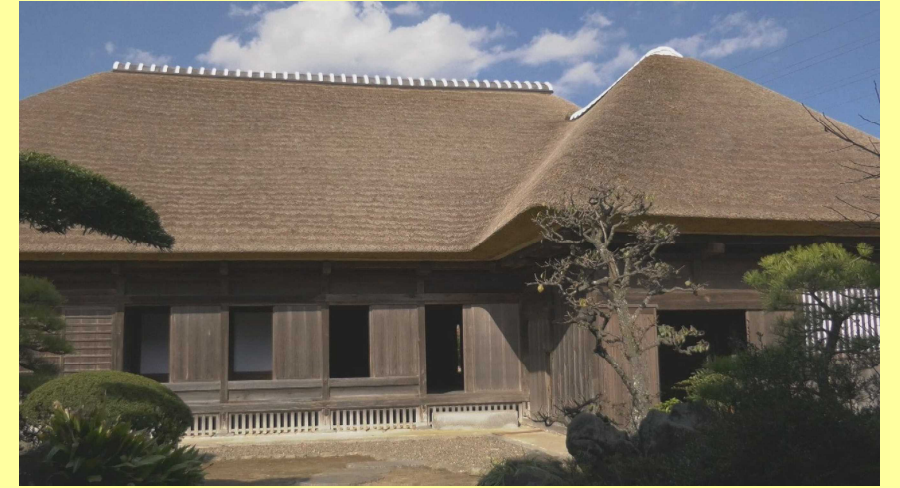
葺替から3カ月後の山本家住宅
