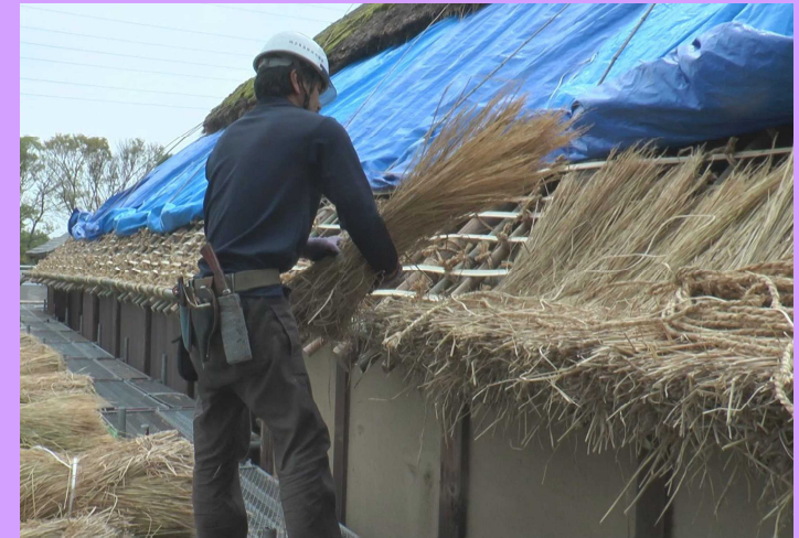
解体されたところから 新しく茅を葺いていきます
