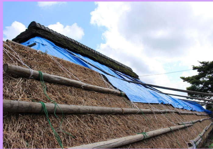
葺かれた部分から さらに足場が設置されます
