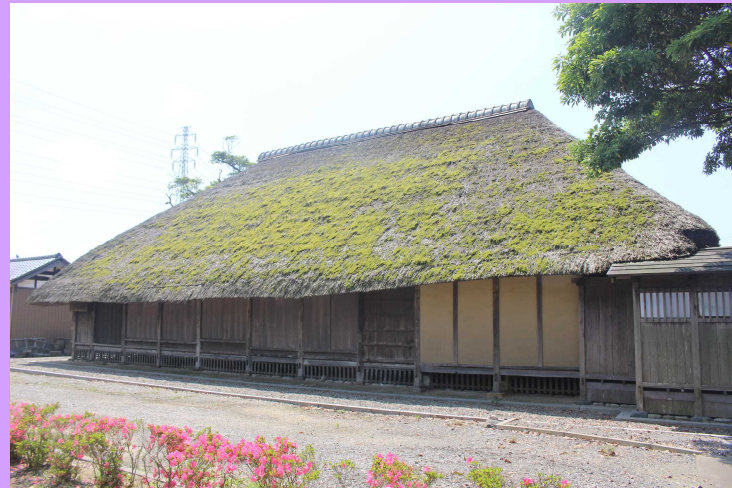
工事前、苔が生えていた北側屋根
