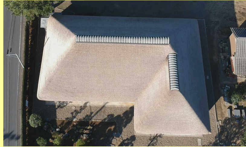
葺替後すぐ、空から見た山本家住宅
