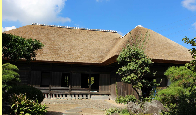
葺替後すぐの山本家住宅
