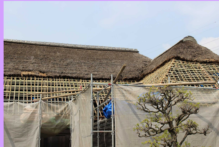
下から茅が解体されていきます
