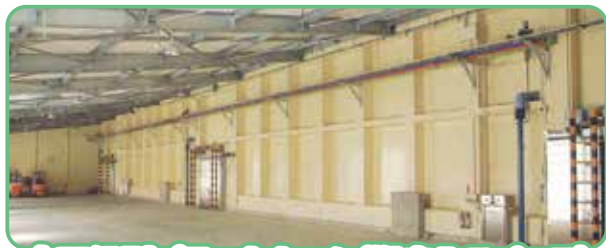
全天候型プラットホーム(搬出入スペース)
