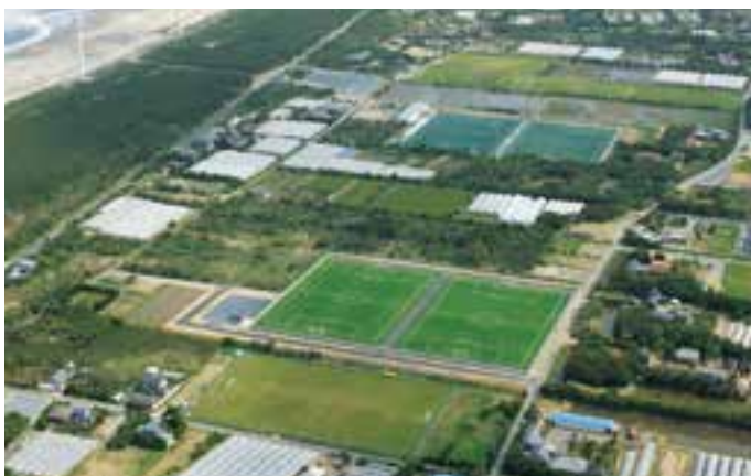
ロングパイル人工芝ピッチを有する矢田部サッカー場
