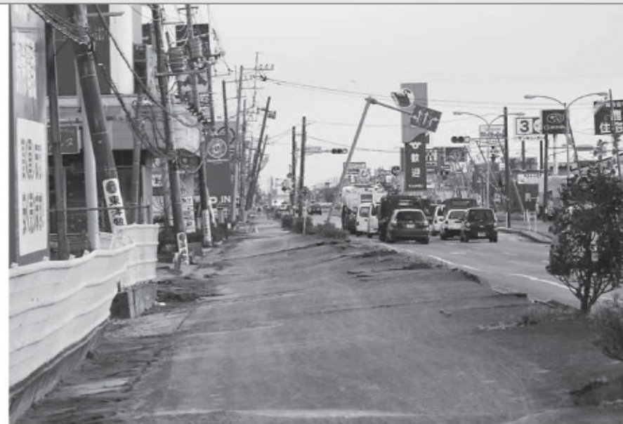
送水管が埋設されている国道124号沿い
