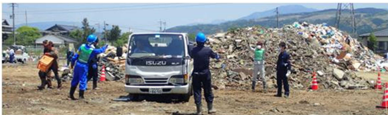
作業員の配置
