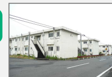
解体する東町住宅
