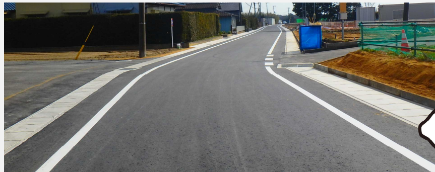
施工後 道路両側へ側溝を整備し、道路全体の高さを上げる等の改修。
