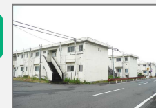
解体した東町住宅
