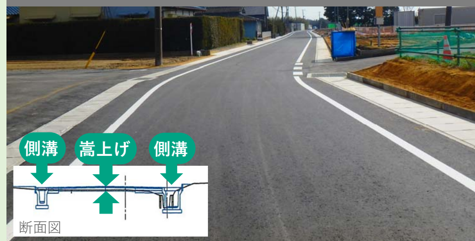
道路の嵩上げと側溝の整備で、排水能力を強化
