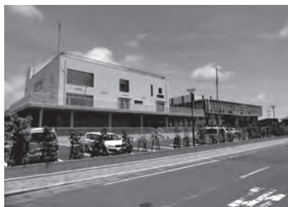
▲ 波崎総合支所・防災センター
