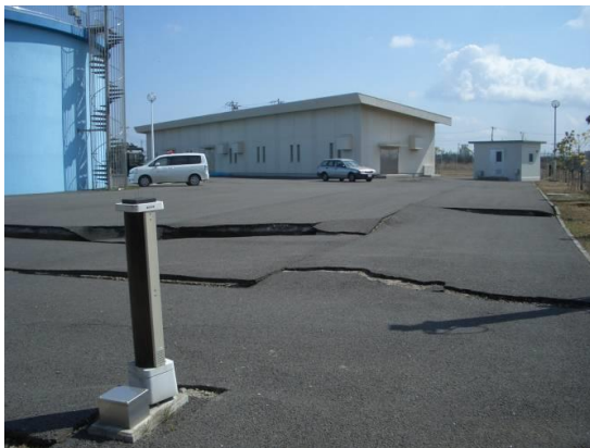
図 2 - 1 1 . 神栖市の東日本大震災における水道施設の被害状況
