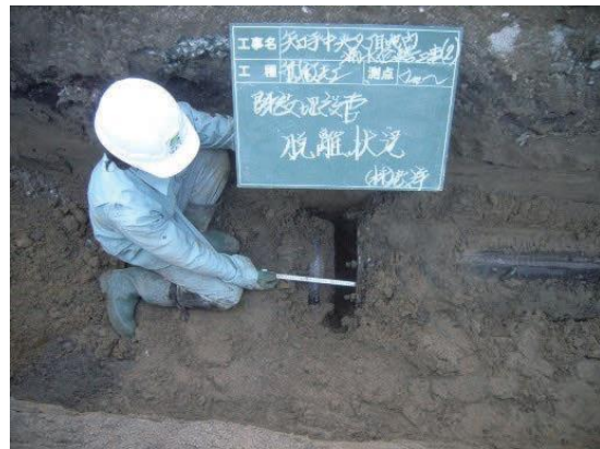
図 2 - 1 1 . 神栖市の東日本大震災における水道施設の被害状況
