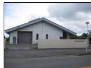
土合第三中継ポンプ場
