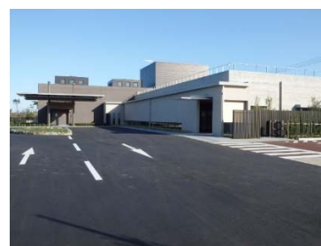
はさき火葬場
