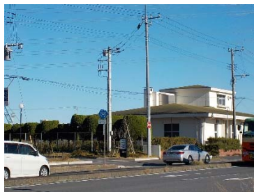
港南中継ポンプ場
