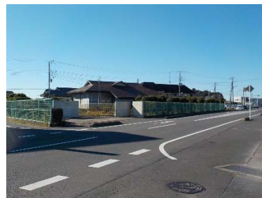
柳堀中継ポンプ場
