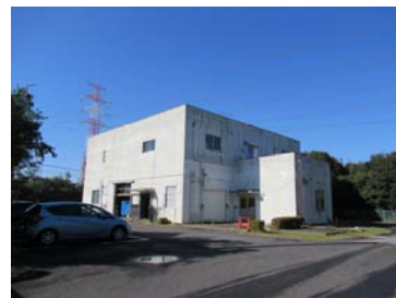
第一衛生プラント
