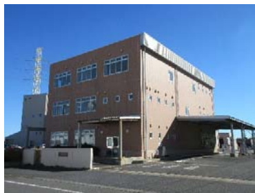
第一リサイクルプラザ
