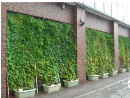
市役所に設置した緑のカーテン
