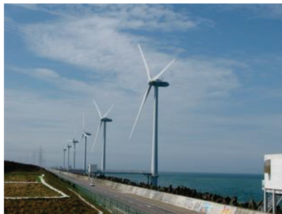
ウィンド・パワーかみす第1洋上風力発電所
