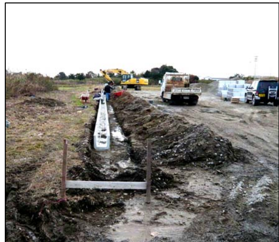
写真：構内敷地造成及び排水溝施工状況
