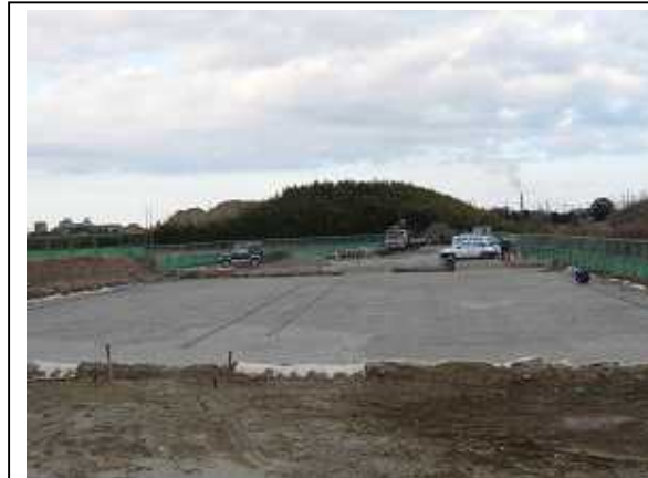
処理棟・貯留槽建設予定地「南端より撮影」
