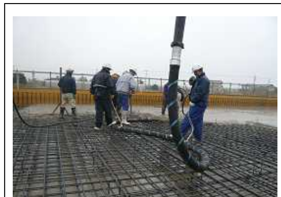
処理棟基礎コンクリート打設状況 「施設建設地北側より南端に向けて撮影」
