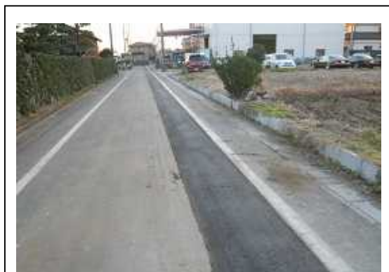
敷地西側前面道路（市道8-486号線）
