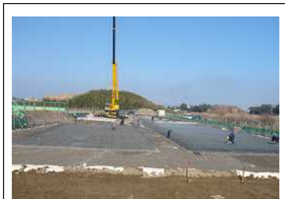
処理棟・貯留槽建設状況「南端より撮影」
