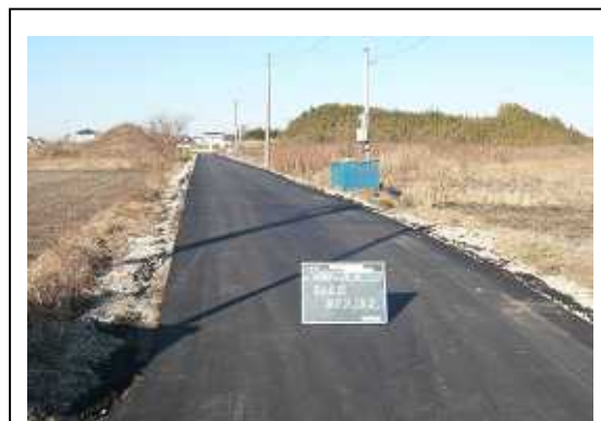
敷地東側背面搬入道路仮設舗装状況
