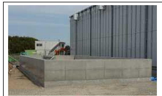
貯留槽設置工事状況
