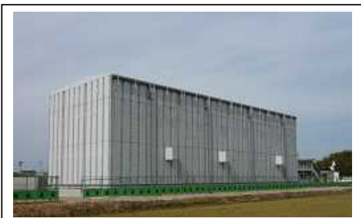
処理棟の全景（東側より撮影）
