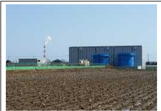
地下水処理設備の全景（西側より撮影）
