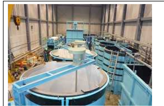
処理設備設置工事状況
