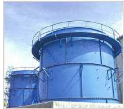
処理水の貯留槽
