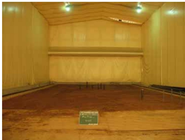
掘削現場内の埋め戻し状況(6月4日時点)
