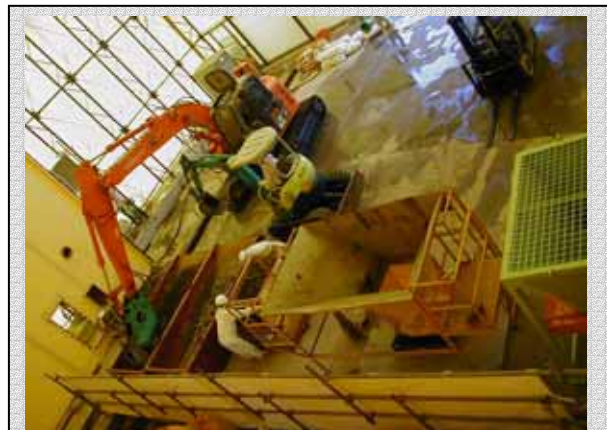
コンクリート様の塊の粗破碎状況
