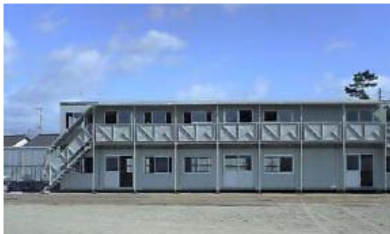
現場事務所の様子(9月22日撮影)
