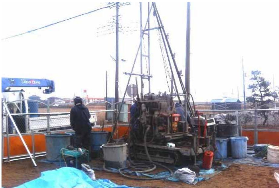
現在設置中のABトラック南西地域揚水井戸
