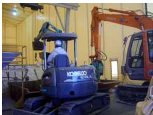
掘削テント内の 土壌分級破碎状況
