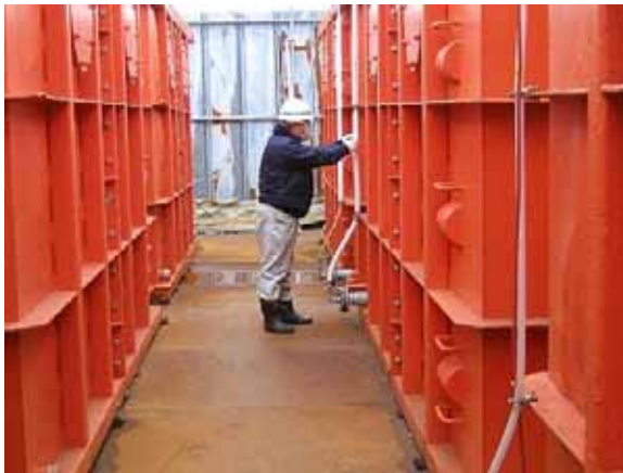
水槽確認作業状況(水処理施設内)
