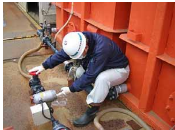
流量計確認作業状況(水処理施設内)
