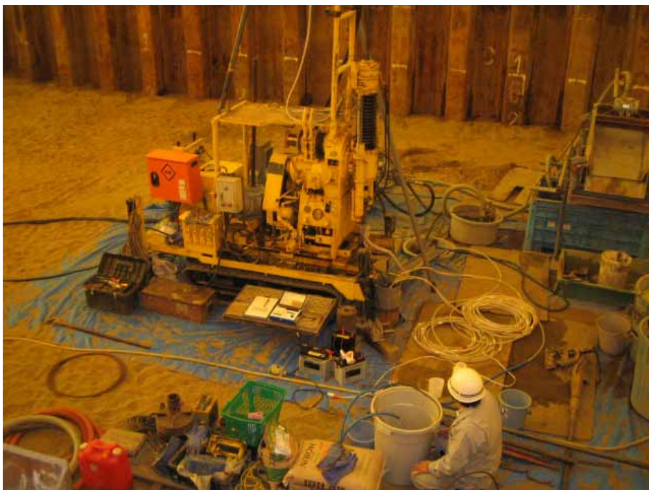
現在設置中の掘削調査地点の状況
