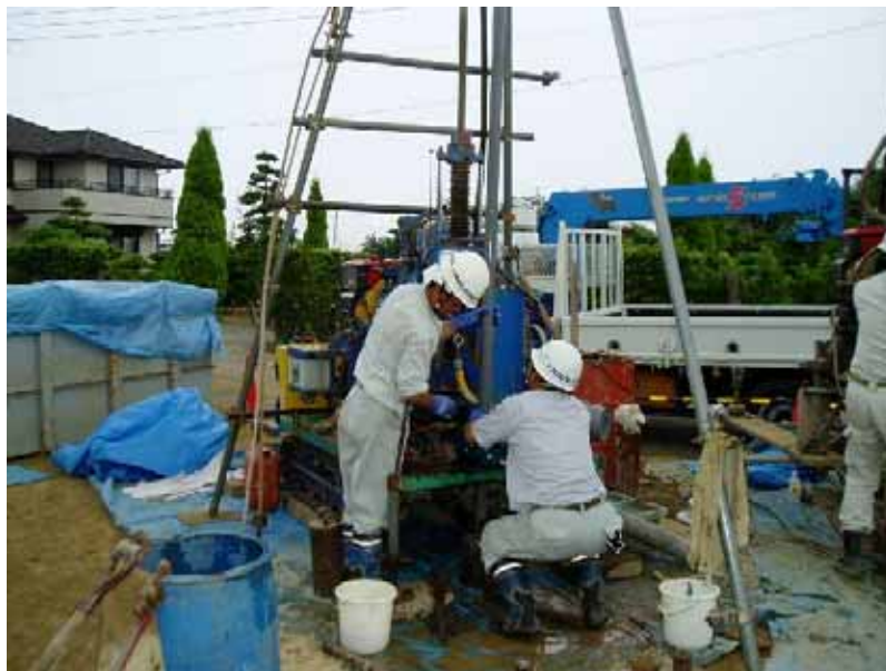
揚水調査用井戸の撤去風景(ABトラック南西地域)
