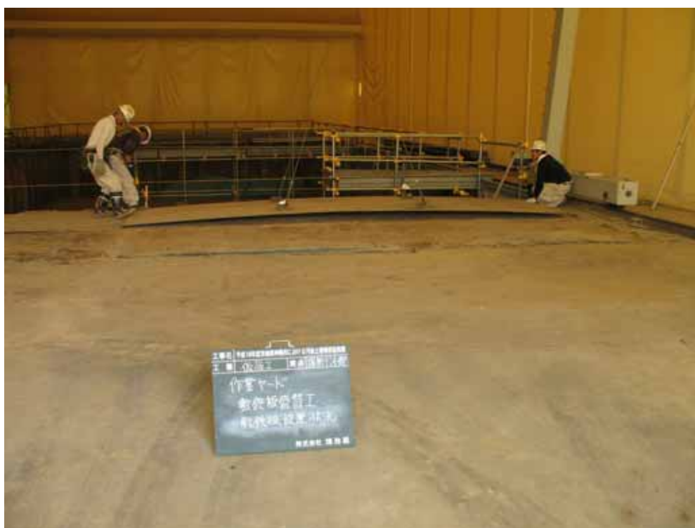
掘削tent内 詰め替え作業場所の整備の様子
