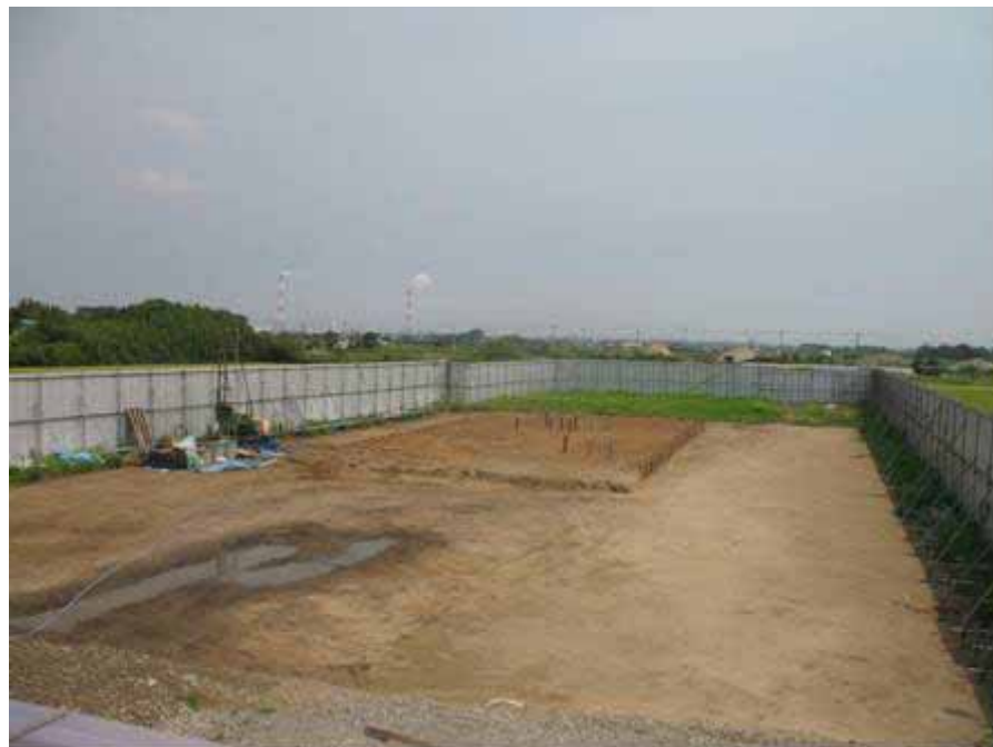
掘削テント撤去跡地の状況
