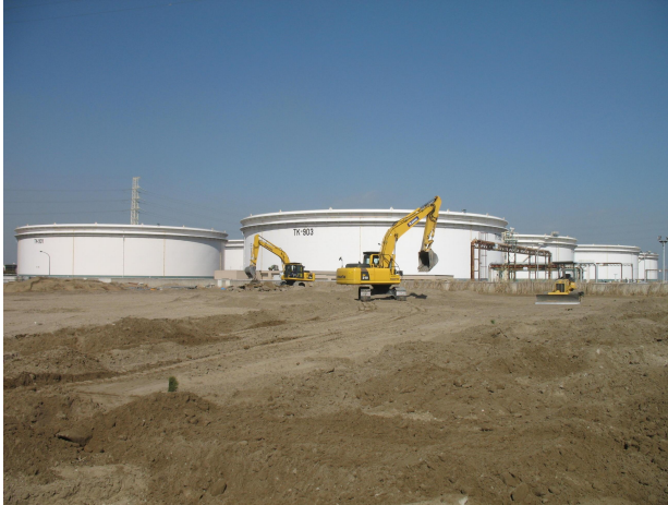
奥野谷保管施設現況復旧工事 整地工事状況（2月28日）
