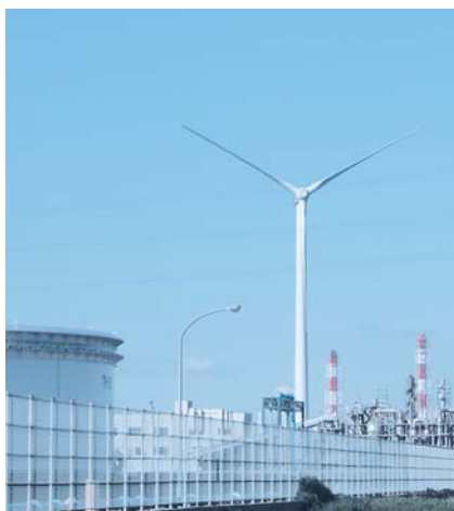
①鹿島石油(株)構内1基
