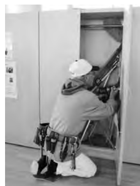
掃除道具入れ（一年生）の ゆるんだネジの修理をして います
