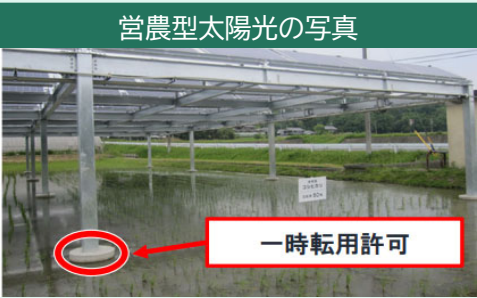
営農型太陽光の写真 ※支柱の基礎部分について「一時転用許可」が必要になります。
