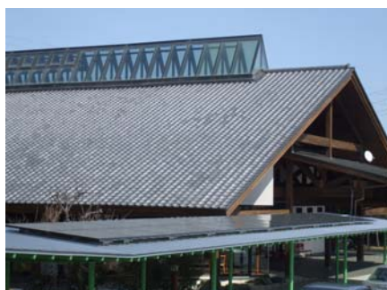
「ゆ〜ぽ〜とはさき」での 太陽光発電システム
