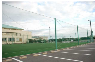
施設が新しいため劣化など特になし
