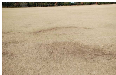
グラウンドの劣化
