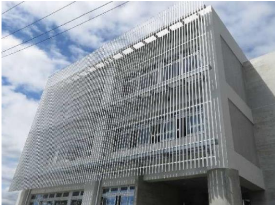
左：太陽光の入射角が制限され室温上昇を抑制するルーバーの設置（神奈川県南足柄市立福沢小学校） 右：地元産材を多く利用し、やすらぎやぬくもりが感じられる廊下（愛知県豊田市立寺部小学校） 引用：「エコスクールー環境を考慮した学校施設の整備推進ー」（平成 29 年 6 月、文部科学省他）
