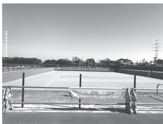
写真1 公共スポーツ施設の様子
