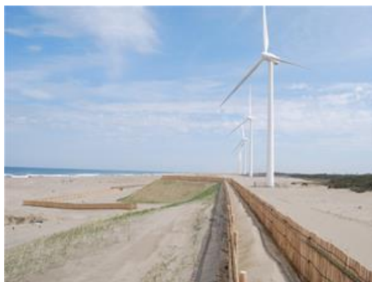
砂丘の造成・堆砂垣の設置
