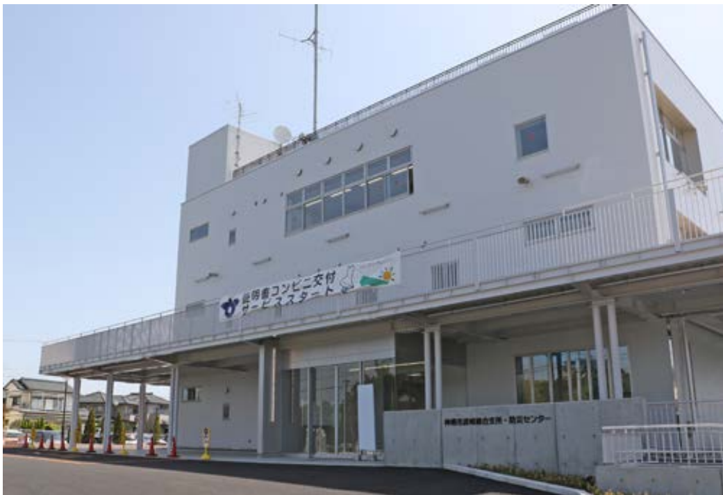
図 2-17 波崎総合支所・防災センター
