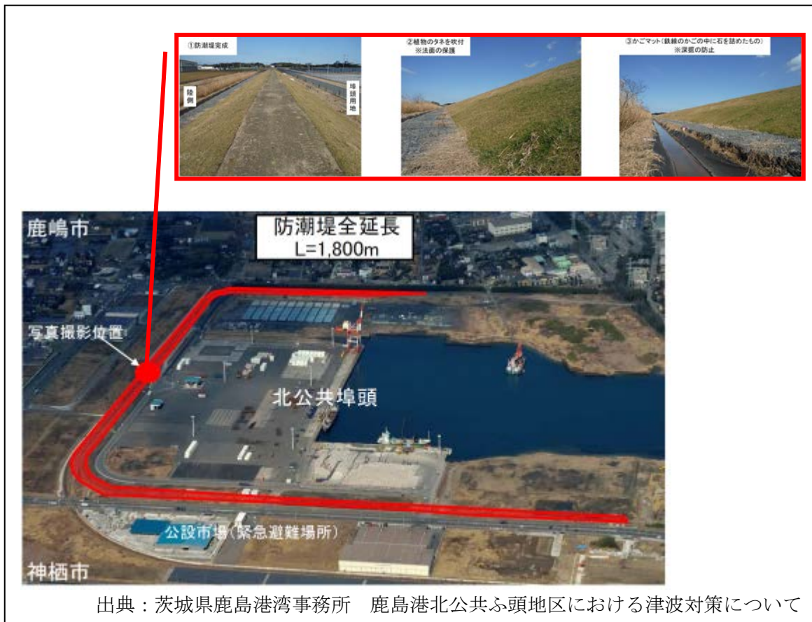
図 2-1 1 北公共埠頭地区の防潮堤整備
