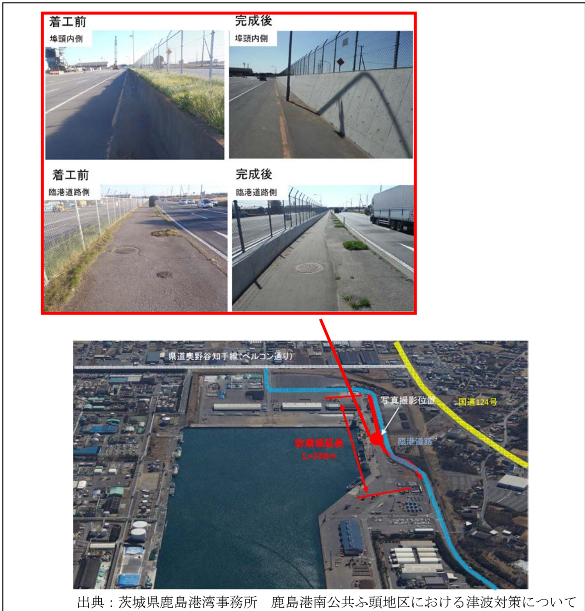
図 2-12 南公共埠頭地区の防潮堤整備
