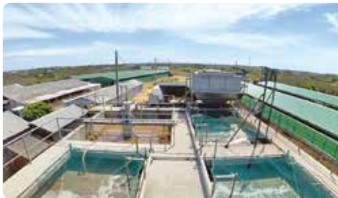
環境に配慮し、巨大浄化槽で汚水をきれいな状態にする
