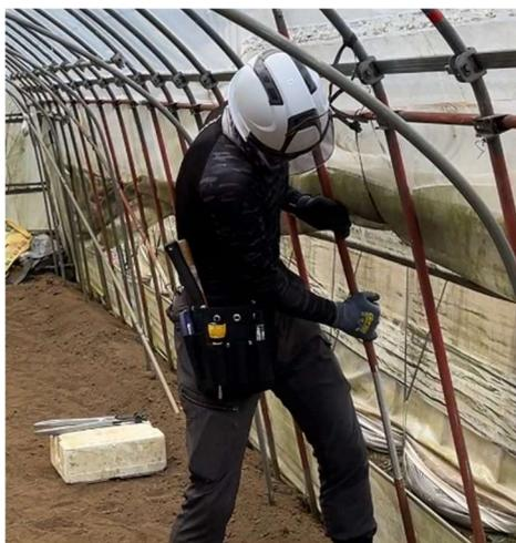
写真7 パイプかしめ器で締める
