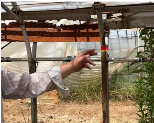
写真2 脚部の腐食
