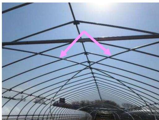
写真3 筋交いの設置間隔 (0~3m)
