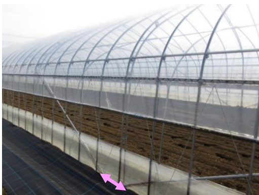
写真3 筋交いの設置間隔 (0~3m)
