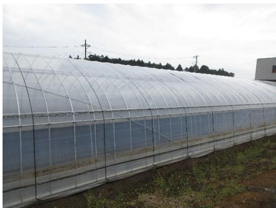
写真1 筋交いの設置状況
