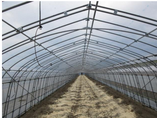
写真2 ダブルアーチの設置状況
