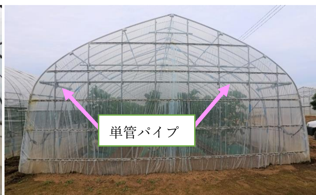
写真2 妻面（扉の反対側）
