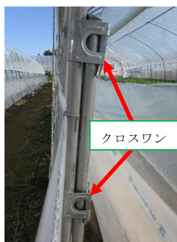
写真2 呼びつぎ法による補強
