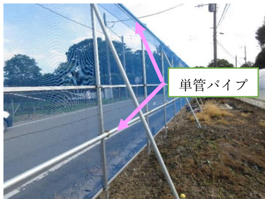
写真5 上部・中部下の横2列の単管パイプ
