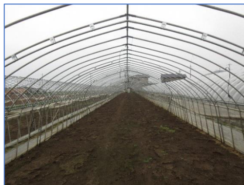
写真2 ダブルアーチ設置状況
