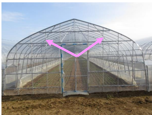
写真3 筋交いの設置間隔 (0~3m)
