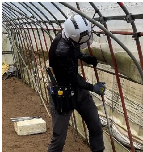
写真5 アーチパイプを上から被せる
