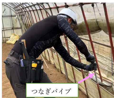
写真6 パイプかしめ器で締める
