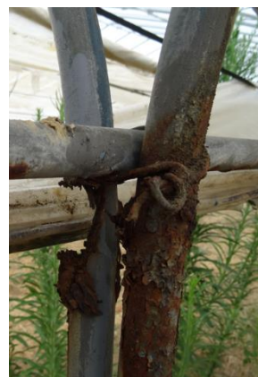
写真3 肩部の腐食
