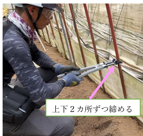
写真6 パイプかしめ器で締める
