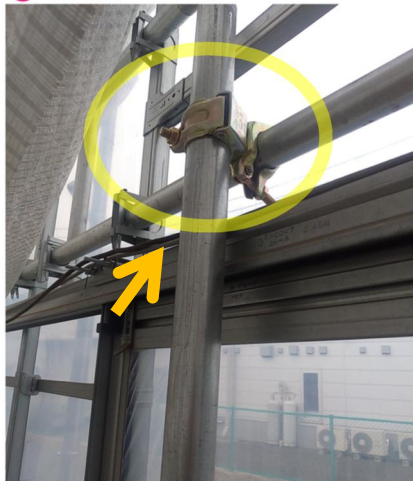
図-25 レール式ドアの補強パイプの取付 （レールが干渉しない場合は、クロス金具により固定）
