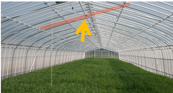
図-31 クロスタイバーによる屋根アーチ部補強
