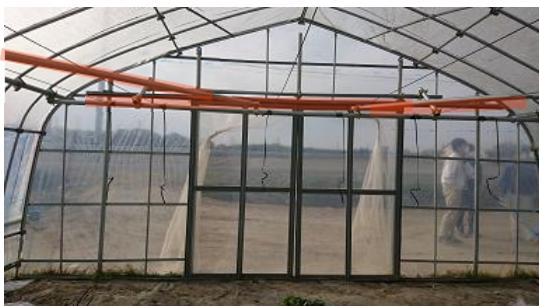
図-28 足場用直管パイプによる妻面補強
