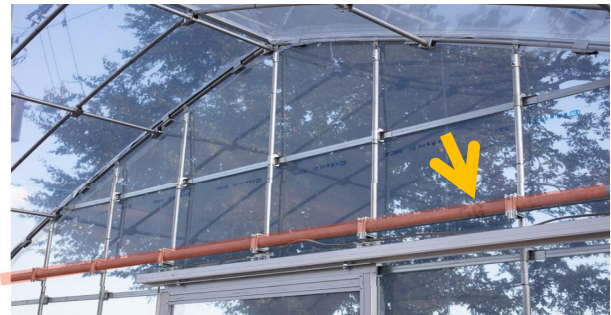
図-32 足場用直管パイプによる妻面補強
