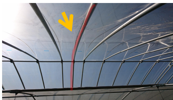
図-37 アーチパイプ増設による強化
