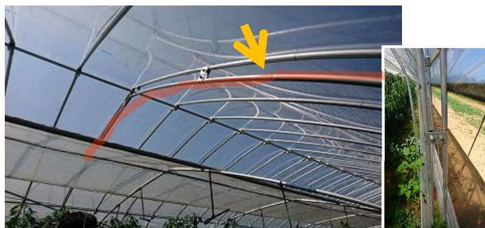
図-36 ダブルアーチパイプで強化
