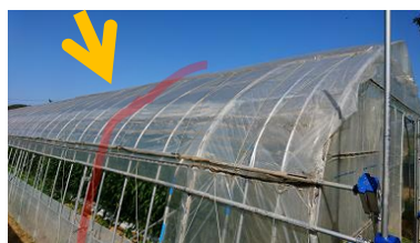
図-38 高温時にハウス肩部の換気ができる新設ハウス
