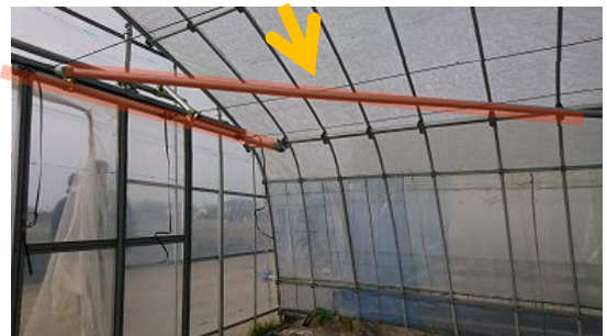
図-27 足場用直管パイプによる屋根アーチ部補強（平常時は交差させた支柱を取り外し作業性も確保）
