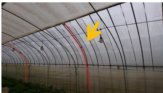
図-33 ダブルアーチパイプによる強化
