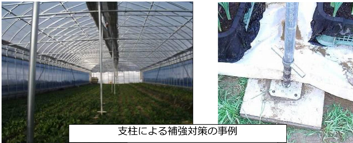
図-41 ハウスの雪害対策（福井県雪害対策マニュアルより）
