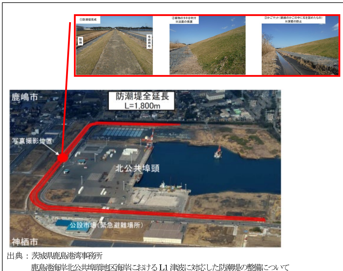
図 2-12 北公共埠頭地区海岸の防潮堤整備
