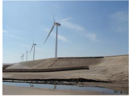
砂丘の造成・堆砂垣の設置
