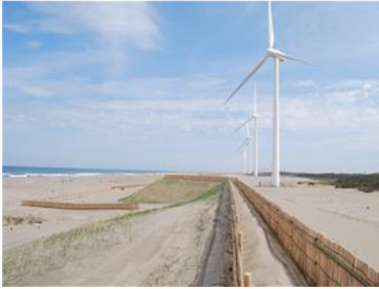
砂丘の造成・堆砂垣の設置
